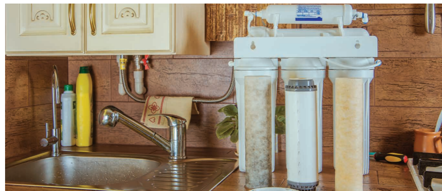
정수기의 핵심은 필터다. 보통 세디멘트 필터, 프리카본 필터, 멤브레인 필터, 포스트카본 필터로 구성된다. © shutterstock.com
